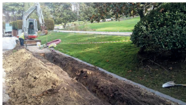
Travaux fibre optique
