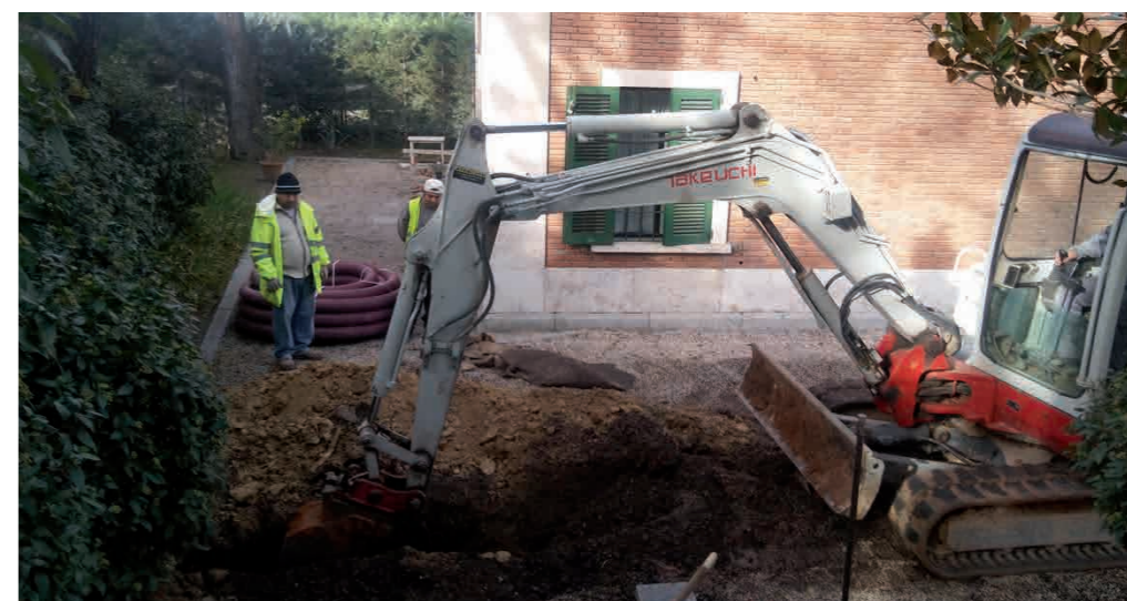
Début des travaux de raccordement à la fibre optique
