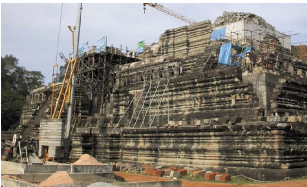
Restauration par anastylose du temple-montagne du Baphuon en 2007 Source : Pascal Royère, EFEO
