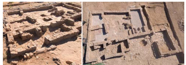
Restauration et mise en valeur patrimoniale d'une maison islamique à Albalat (Estrémadure, Espagne) : a) avant restauration ; b) après restauration [© S. Gilotte, Mission ALBALAT]
