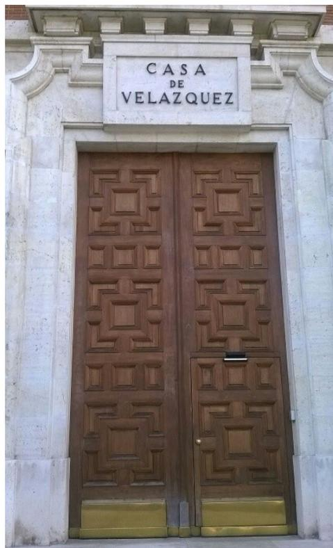
Las labores de mantenimiento correctivo de carpintería y barniz incluirán la limpieza de herrajes, relleno de fisuras y tratamiento antixilófagos.
